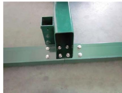
Die Querstreben zur linken und rechten Schiene mit den Schrauben, Unterlegscheiben und Muttern befestigen.
